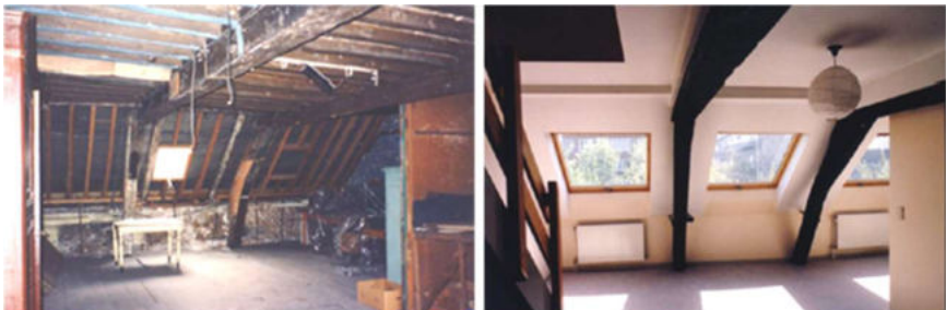
une pièce sous toit, avant et après rénovation !
